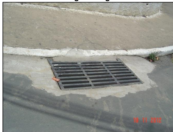
Figura 32 – Boca de lobo no distrito de Vargem Alegre
